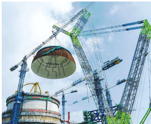
「華龍一號」漳州核電2號機組穹頂吊裝。
